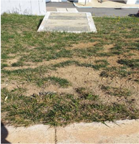
espace des ouvrages de coagulation-floculation-décantation
