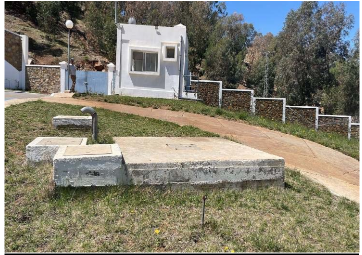
fosse septique eaux domestiques
