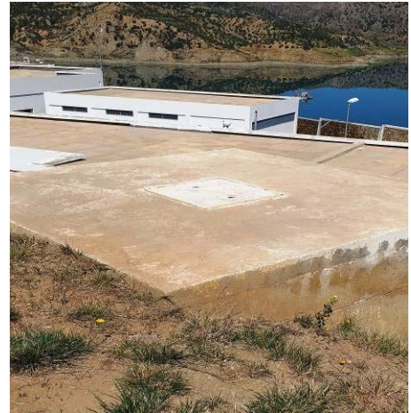
fosse des vidanges de systèmes de neutralisation
