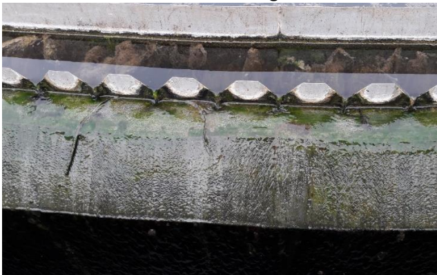
Figure 26 : Seuils dentés avec un écoulement presque nul
