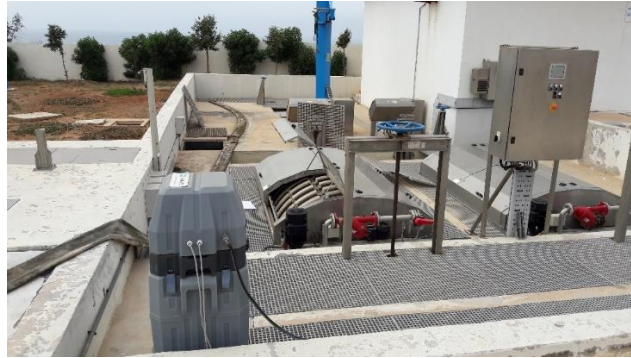
Figure 31 : Disposition des équipements du traitement tertiaire
