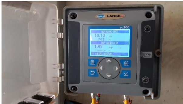
Figure 16 : Affichage des paramètres physicochimiques du réacteur biologique (pH, Température et O 2 dissous)
