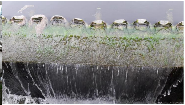
Figure 25 : Seuils dentés presque immergés induisant un fort écoulement dans cette zone
