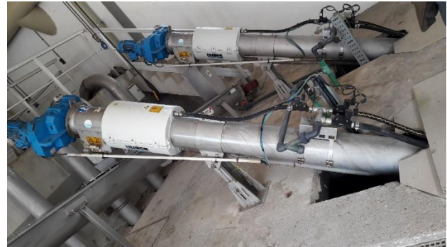
Figure 9 : Dégrilleurs fins
