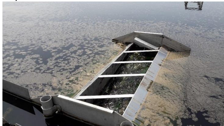
Figure 28 : Réalisation d'un trou dans la trémie de récupération des flottants pour diluer les boues de la fosse à flottants
