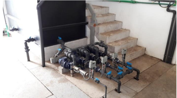
Figure 37 : Les 4 pompes doseuses du polymère (3+1)
