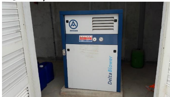
Figure 18 : Surpresseur d'air pour le réacteur biologique des graisses fonctionnant sans secours
