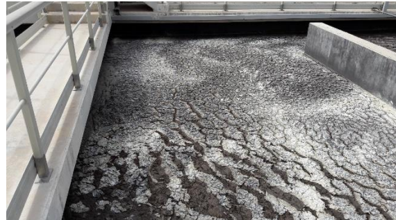
Figure 20 : Boues importante en surface des zones anoxies du bassin 2
