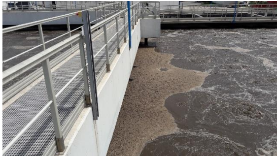
Figure 19 : Présence de boues flottante assez consistante dans le bassin 1
