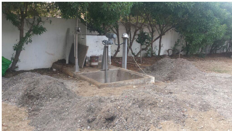
Figure 44 : Matériaux récupérés de la conduite reliant le DO et l'entrée STEP après un évènement pluviale
