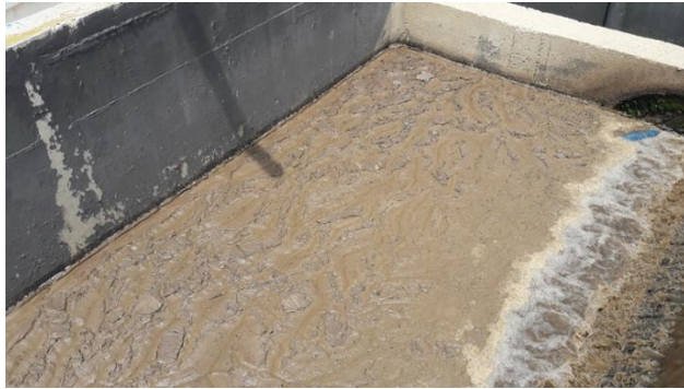
Figure 22 : Boues flottante au niveau des dégazeurs
