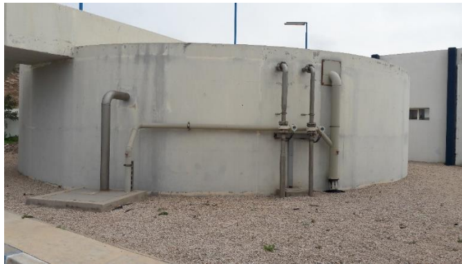
Figure 33 : Ouvrage d'épaississement
