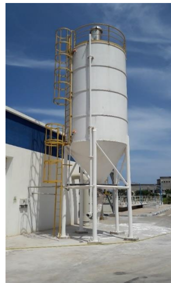
Figure 39 : Silo de stockage de la chaux vive
