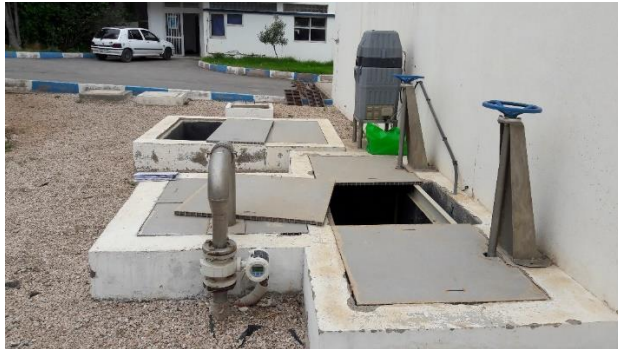
Figure 8 : Ouvrages en amont du prétraitement (mesure de débit, répartition, isolement par vannes, échantillonnage, apport des eaux usées du bâtiment d'exploitation)
