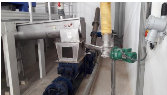
Figure 38 : Injection et mélange de chaux/boues déshydratées au niveau de la pompe gaveuse
