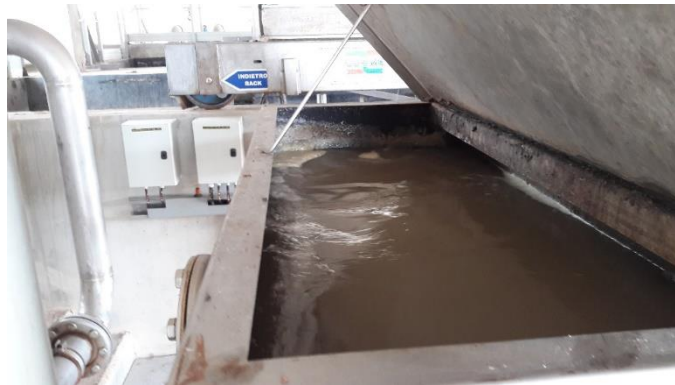
Figure 15 : Surcharge hydraulique du classificateur à sable
