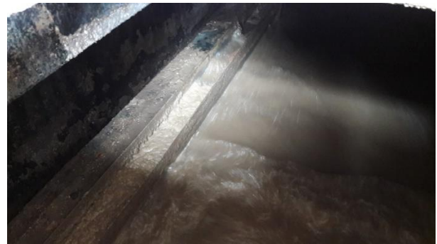
Figure 17 : Seuil de sortie du réacteur biologique sans déversement vers le canal menant vers et la fosse toute eaux
