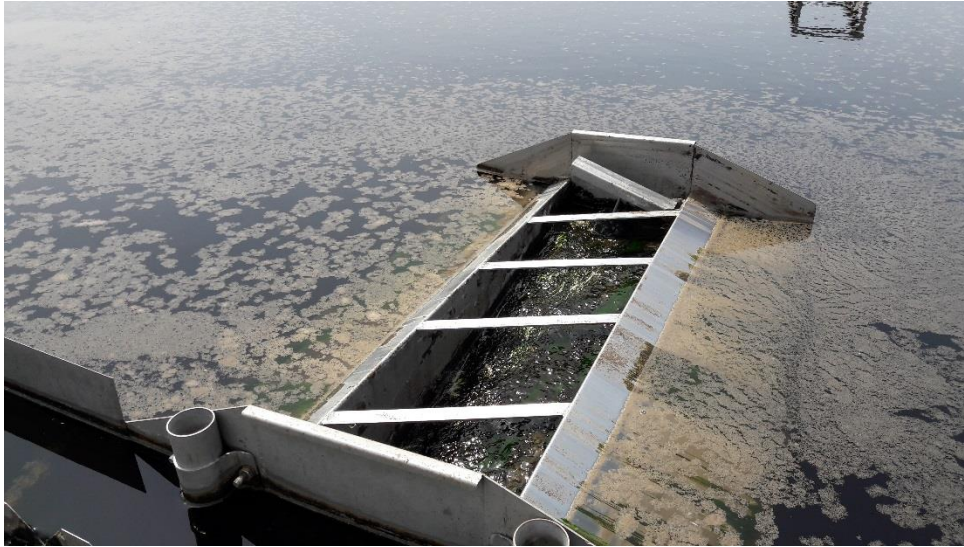
Figure 45 : Trou réalisé dans la trémie à flottant pour diluer les flottants récupérés dans la fosse
