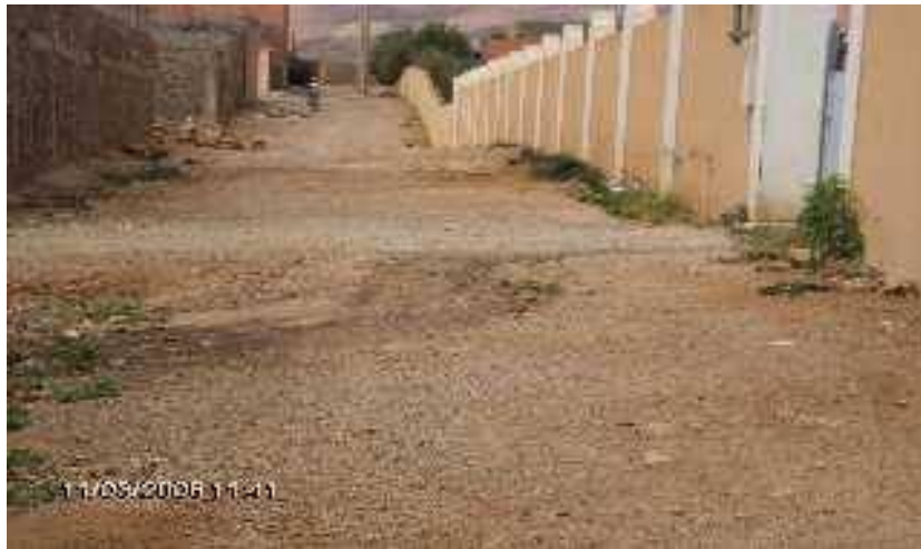
Photo N°1: Ecoulement des eaux usées dans les rues
