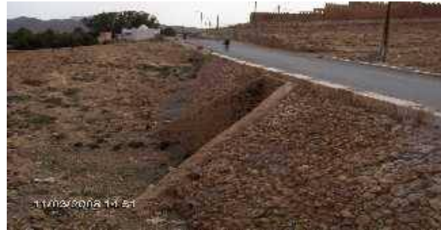
Photo N°6: Ouvrage d'art sur oued Talawchen
