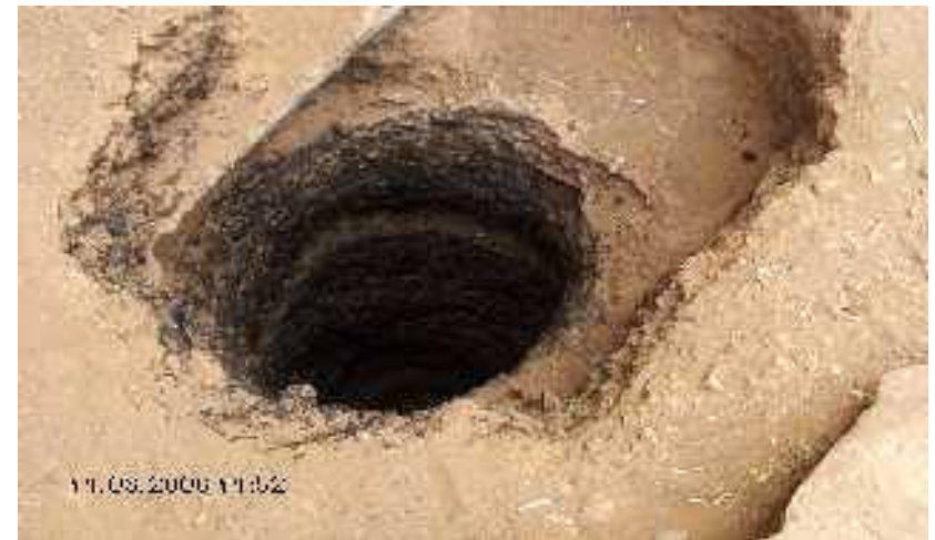
Photo N°4: Puits perdu pour l'assainissement
