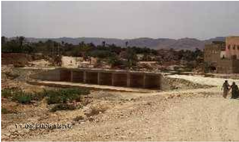
Photo N°5: Pivrage d'art en cours de construction reliant les deux rives du centre
