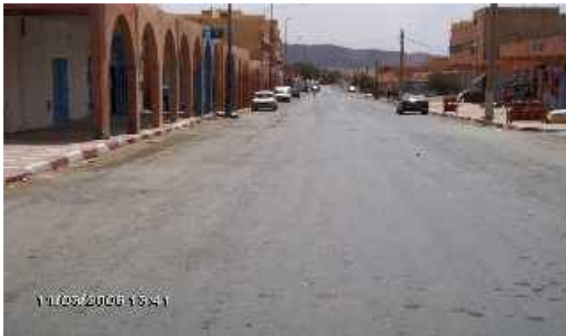
Photo N°7: La route RP1919 traversant le centre
