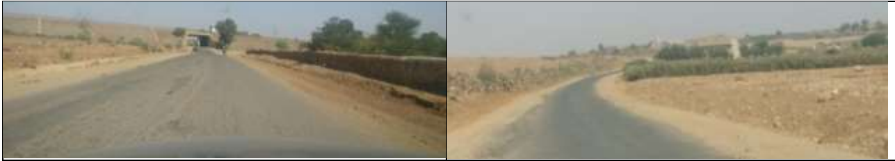
Emprise de la conduite d'amenée (route P2107)
