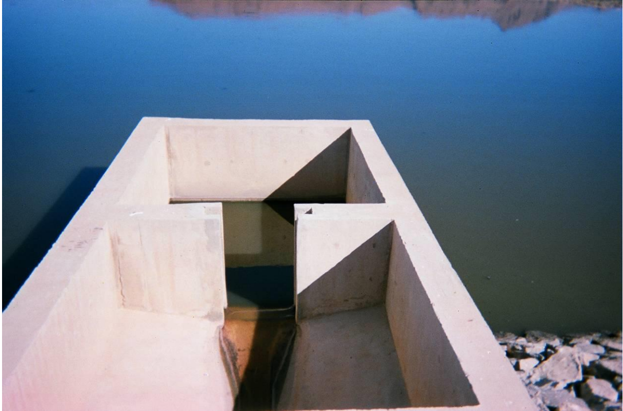
- Photo 6 : Ouvrage de sortie
