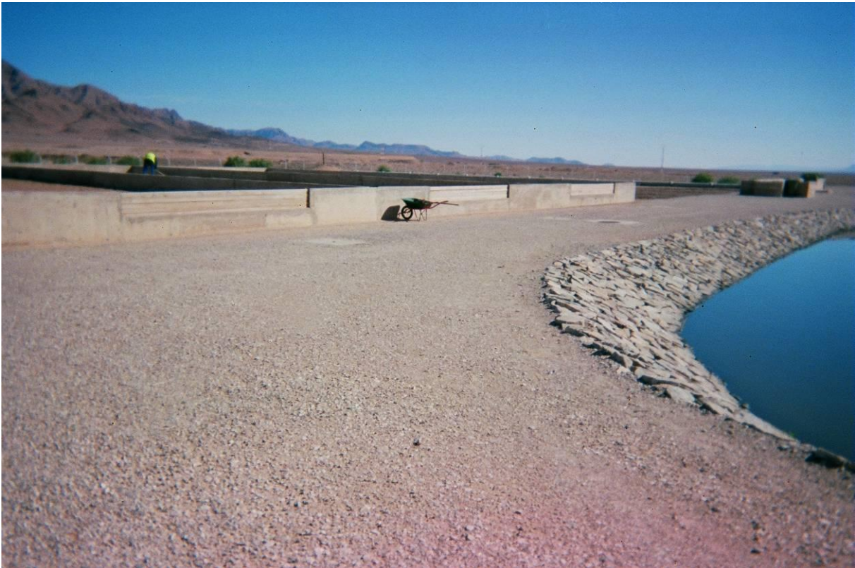
- Photo 4 : Lits de séchage + piste d'accès aux digues
