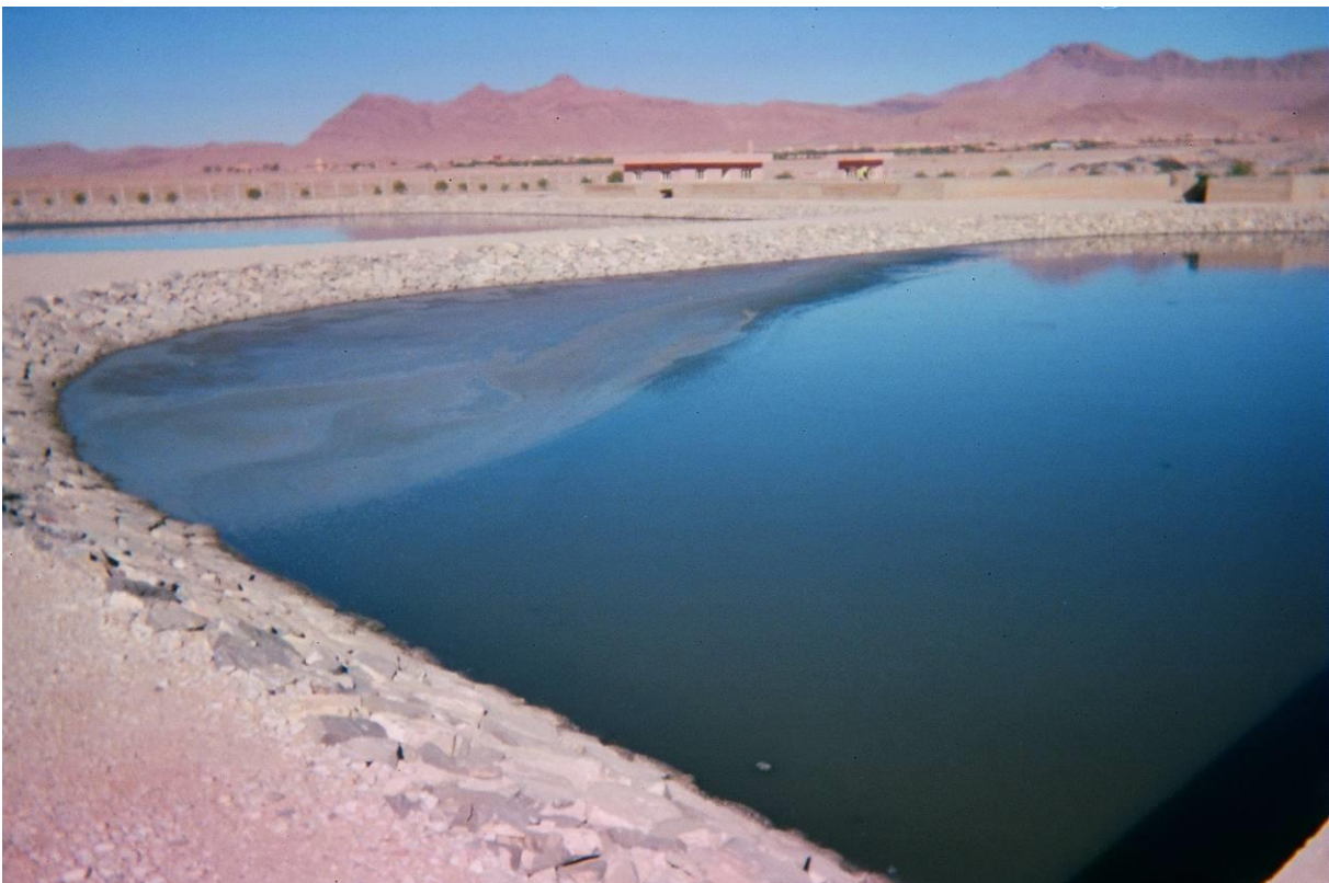
- Photo 5 : Lagune anaérobie
