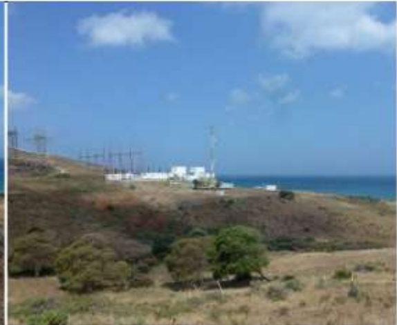
Vue de la centrale électrique de l'ONEE Branche Electricité (Ouest Projet)
