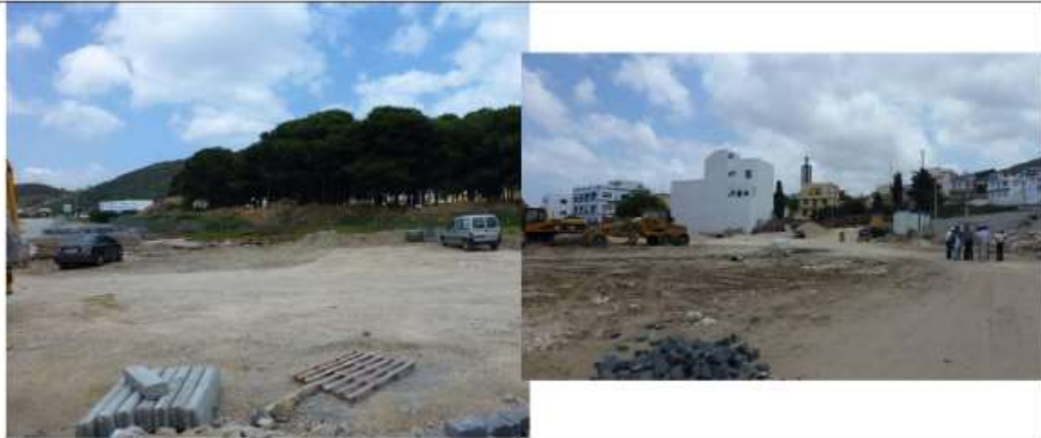
Emplacement SP2 : Parking en construction ; présence d'un dalot pour l'évacuation des eaux pluviales
