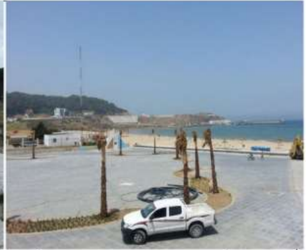
Aménagement de la Corniche à Ksar El Majaz
