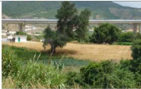
Pont à poutre pour passage de l'autoroute et de la voie ferrée
